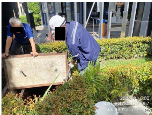
บ่อตรวจสอบสภาพน้ำทิ้งก่อนระบายออกจากโครงการ
